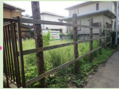
〈改善後〉柵の設置
