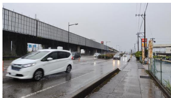
交差する主道路（国道 8 号） 車線数が多く、跨線橋から合流してくる車両もあり、交通量が多い。また、走行速度も速い。
