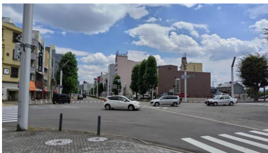
主道路・従道路とも車線数が多い
