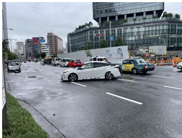
工事等により見通しも悪い
