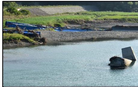
森山地区の橋が流されていた。
