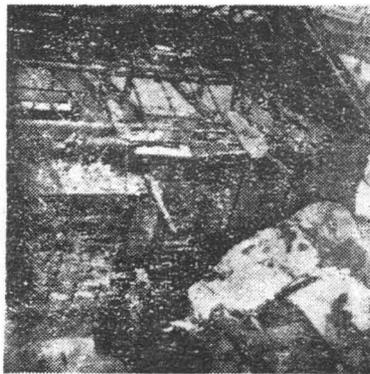
この丸興果物店の木造瓦葺二階建は裏面(西側)から火焰をうけて、瓦葺の屋根が燃えているのであるが、意外にも側面の羽目板は殆んど焦痕さえ目立つておらない。即ち火焰は軒先に吸込まれて屋根裏を燃え上つたと
