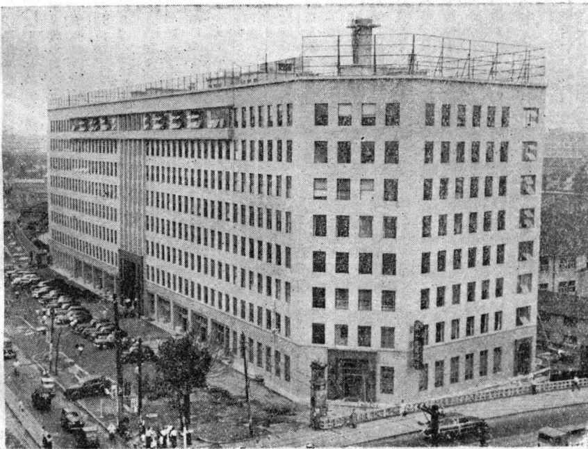
昭和二十六年能美式ヲ裝置シタ東京日本橋鐵鋼會館
