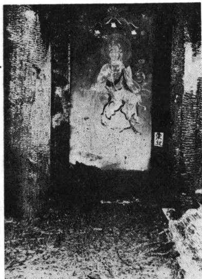
写真は法隆寺金堂壁画 昭24. 1. 26. 電気座蒲団が原因で罹災焼 失す
