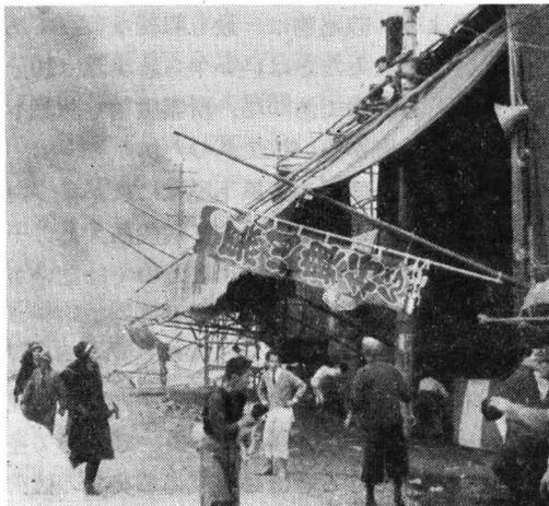
この種興行場に対しては、各地とも同様の取扱をしているものと考えられるが、第4種消火設備は簡易であり、或る程度の設備要請も可能であるが、火災の場合（出火場所によるが）有効に使用可能の状態を保持できるかどうか、この度の火災においては、客席後部から出火しているので、壁際の人波により返えされて初期消火は不能であつたであろう。また燃焼しやすい天幕であり、屋根高も相当あるので、少くとも注水距離の大きい第1種口の消火設備が必要と思料される。
