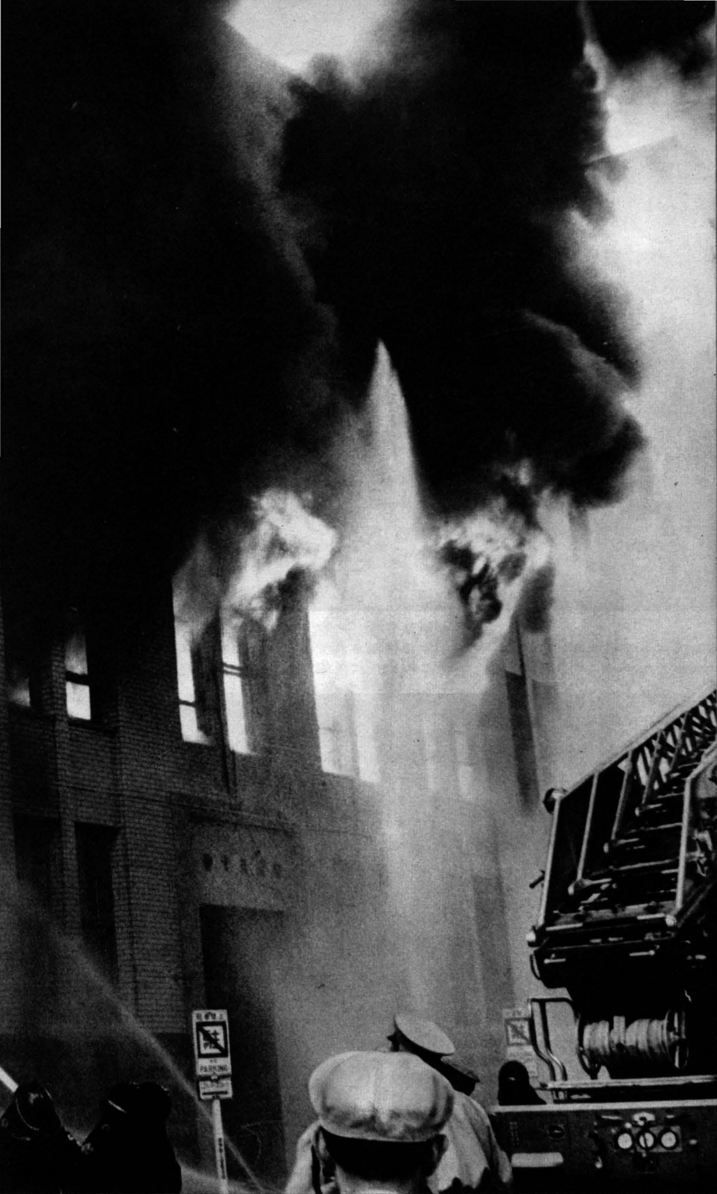
建築物であるが、このようなビルを使つての火災実験は全国でも初めてのことであった。第1日目は地下室を火点とした実験、第2日目は2階を火点とした実験で、暁のビル街は取り囲んだ消防車、係員そして報道関係者で時ならぬ混雑をしめた。
