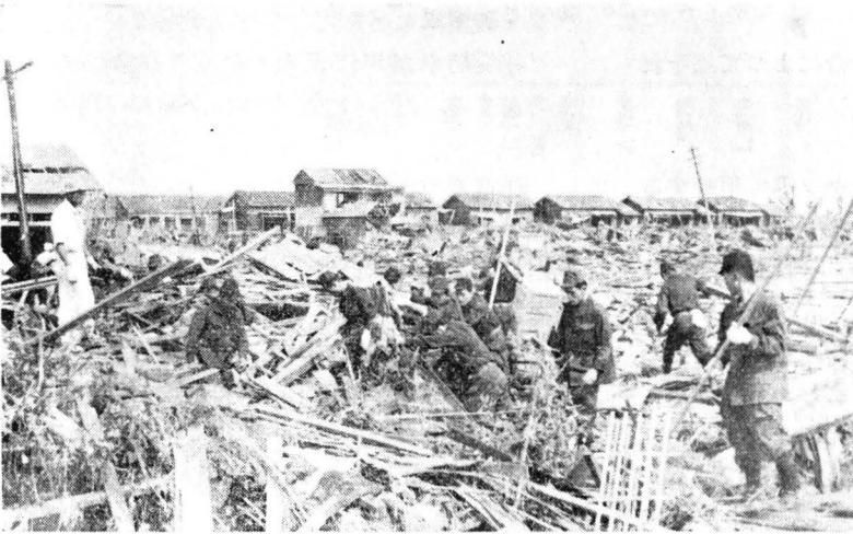
伊勢湾台風の復旧作業（高潮被害のひどかった愛知県半田市日の出町）。
