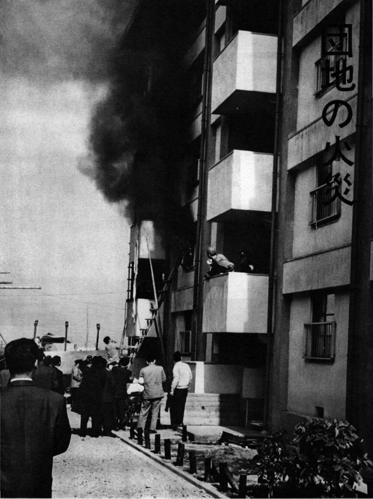
去る3月5日の午後、東京都北区の赤羽台団地の一副で中層耐火造共同住宅が火災になった場合の実験が行なわれ、成功のうちに終了したが、耐火造の強さを見つけた実験であった。
