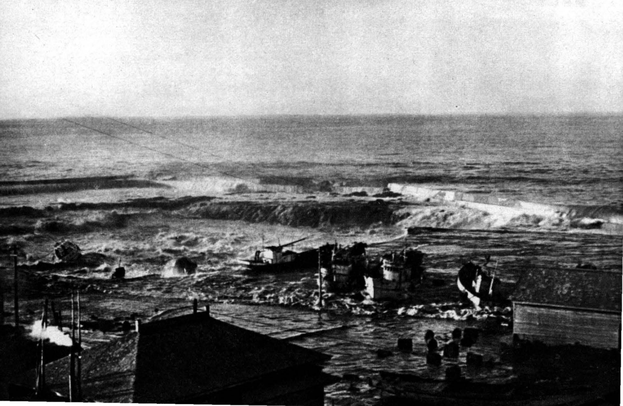
中央仕切りケーソンは欠壊し、港内の漁船は工事中の新船入瀬（基準面より -3.0m）になだれ込み、船舶の被害はさらに大きくなった。
