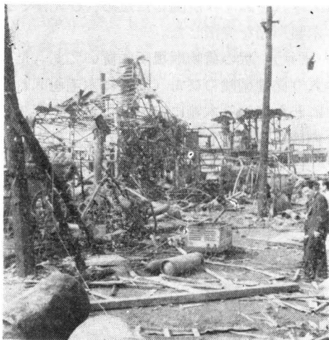
写真 2 熱硝酸塩とタール物質が混融して大爆発した工場
