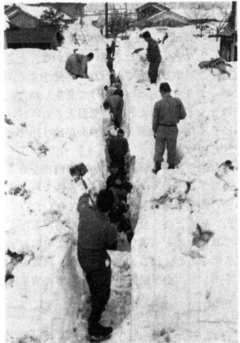
写真 10 洪水防止の堀割り作業
