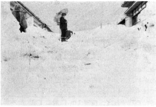
写真 2 除雪により屋根にたする
