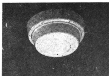
自動 火災報知装置
