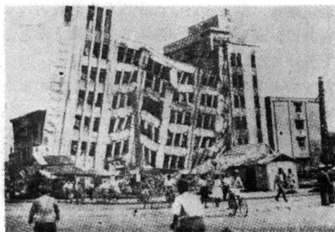
写真 2 福井地震火災における大和百貨店被災状況 (昭23年6月28日) 福井地震災害調査報告10頁
