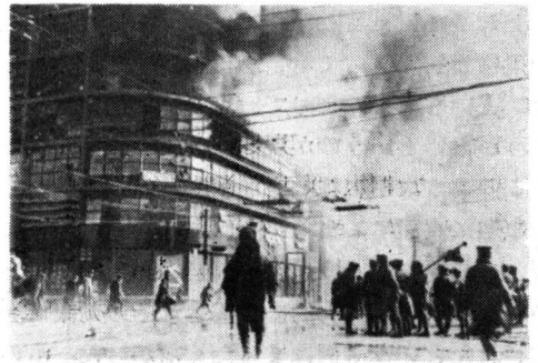
写真1 白木屋火災の消火活動の状況(昭7年12月16日)
