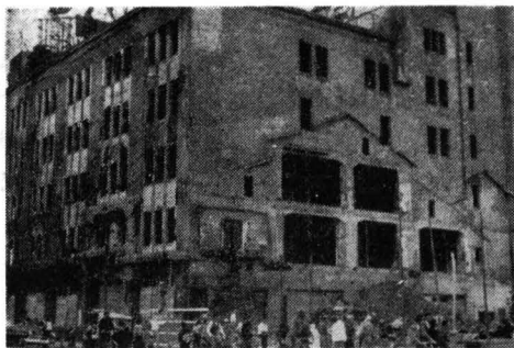
写真 4 小林デパート被災状況；隣接の木造映画館とこのデパートの境の通路として利用していた箇所の防火とびら不完全によりデパートに火を呼び入れたもの。
