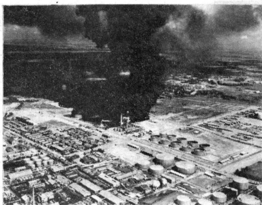
新潟の石油タンク火災（6月16日、地震直後）
