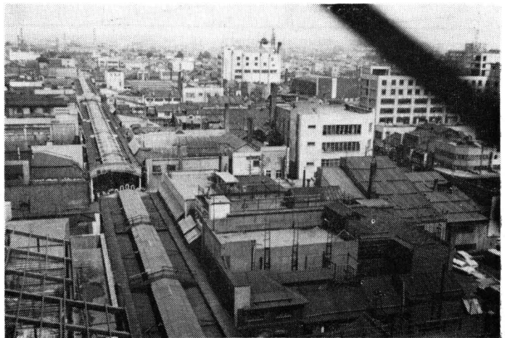
上から見るとバラックの密集で、街区全体が1むねの大面積木造でおおわれているような状態である。消防作業のために立ち入ることもできない
