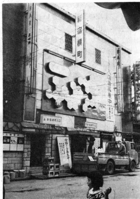
この“新宿横町”の内部はデラックスなムードの酒場であるが、さて、その迷路のようなせまい廊下は、プリントベニヤの天井や壁で、火が出たら生命のほども……
