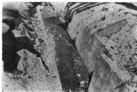
第5図 断層運動の進行によって生じた裂け目
