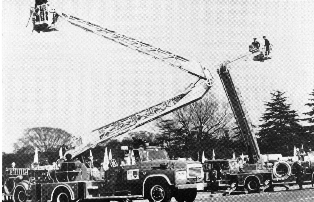
屈折はしご付き消防ポンプ自動車の消火
