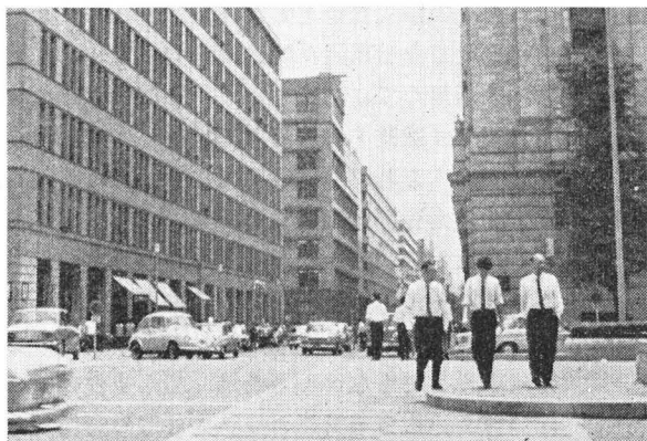
混在ビルはとくに防火管理上の問題が多い
