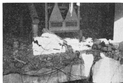
写真2 破壊したサイロ上部
