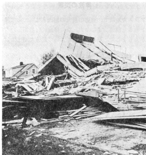
倒壊したリフトスラブ工法によるビルと無被害の木造家屋=左端
