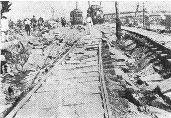
関東地震でひび割れた市電道路
