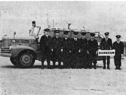
自治体発足当時：水槽付き消防車が登場
