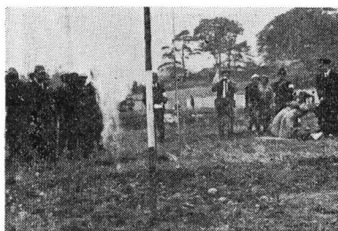
低圧水取器立管の切損燃焼状態
