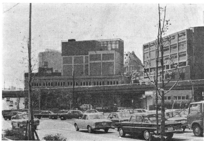
三宅坂換気所（三宅坂施設管制所）
