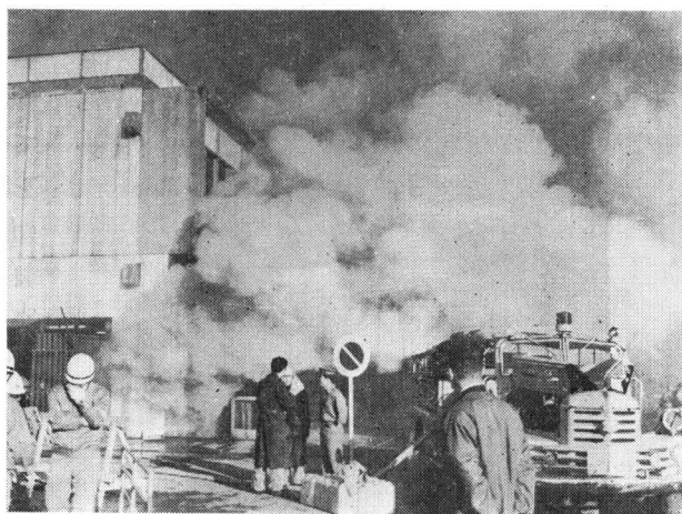
濃煙を吹き出す旭川ステーションビル
