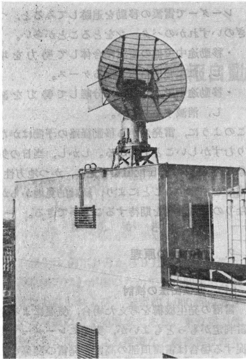
写真1 田端レーダー基地屋上 (パラボラ・アンテナ直径3m)
