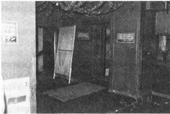
エレベーター脇に階段室に通ずる扉がある
