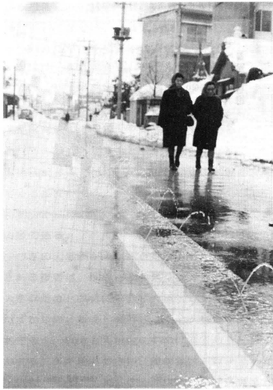
写真2 雪の名所長岡市の大通りでは、このような消雪パイプから噴水する地下水で雪を融かし雪害を克服している。
