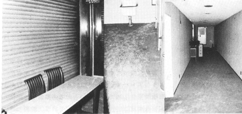
2-② エレベーターホールから防火シャッターをみる。端の部分に煙のふき出しがみられる。
