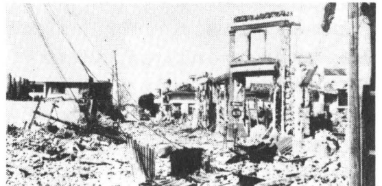
市中心部の崩壊状況
