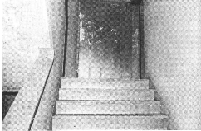
4-① 階段室から、開いていた4階防火戸をみる。
