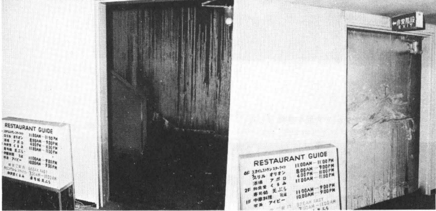
5-① エレベーターホールから階段室をみる。
