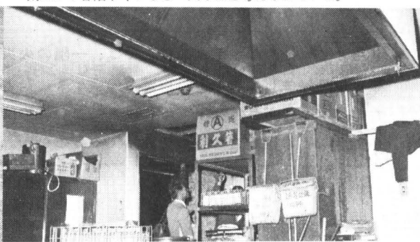
I-⑧ 食器洗い場、湯沸場、天井に見えるのがレンジ風洞。宴会場の煙を上階へ運んだ。これが屋上で風のため逆流して排気口から各階トイレなどへ入ったと考えられている。
