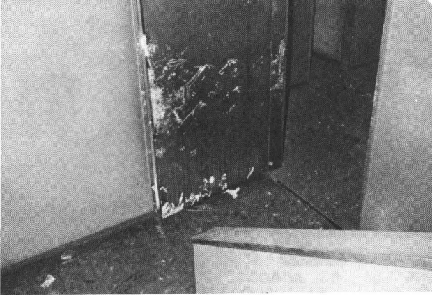
4-② 階段室から、開いていた4階防火戸をみる。
