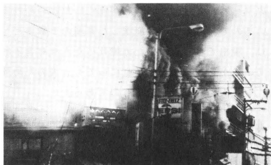
ルーズベルト通り商店街の延焼状況
