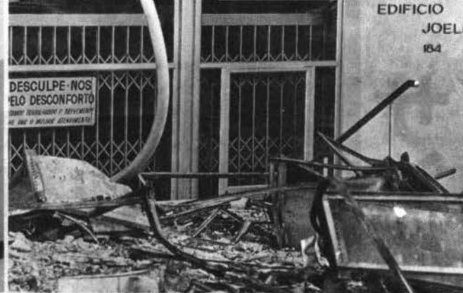
写真-3 一階正面入口と落下したルームクーラーの残骸。
