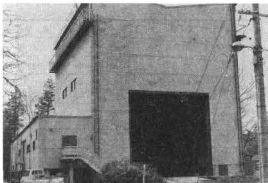
写真5 鉄道技術研究所に新設された燃焼実験室 燃焼室床面積 15m×20m=300m 2
