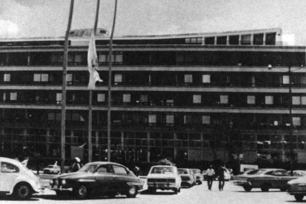
市庁舎 ガラスが割れている
