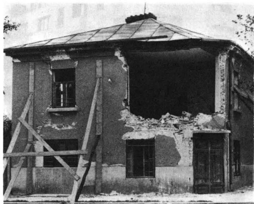
崩れた民家（クライオバ）
