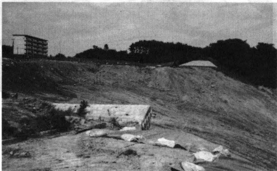
写真9 地すべりを起こした団地
