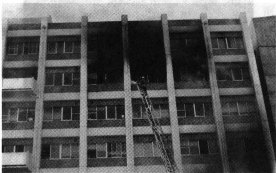
写真10 薬品による火災
