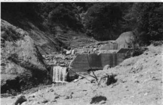
写真12 そでが破壊された砂防えん堤 (53.7.15)
