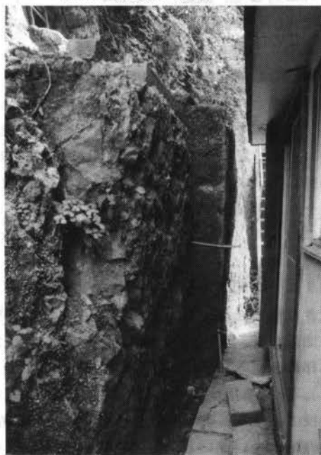
写真2 民家の裏の崖に現れた水平ずれ断層(伊豆半島沖地震、1974)
