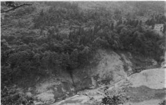
写真12 そでが破壊された砂防えん堤 (53.7.15)
