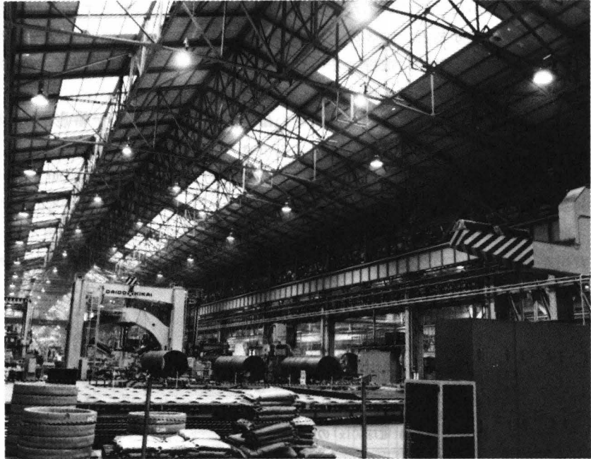
自然光を充分生かした工場照明：高圧ナトリウムランプ
