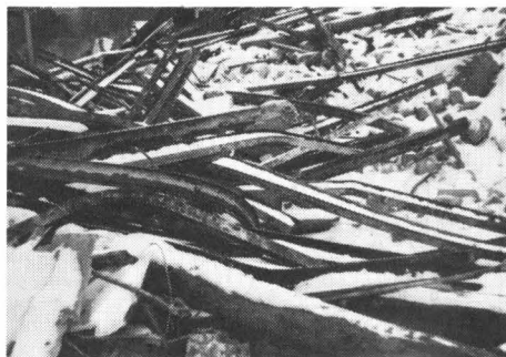
写真3 鉄骨および木の床ばりが落ちたものを集積したところ（アベリーノ）
