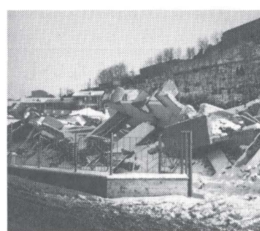
写真8 倒壊した鉄筋コンクリート造アパート（サンタンジェロ）
