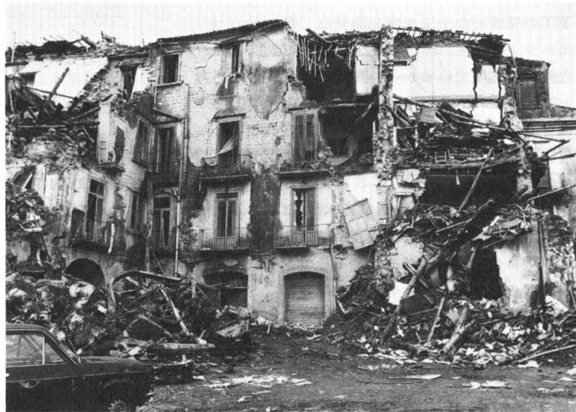
写真4 石造建築の被害（アペリーノ、同市役所の提供による）
