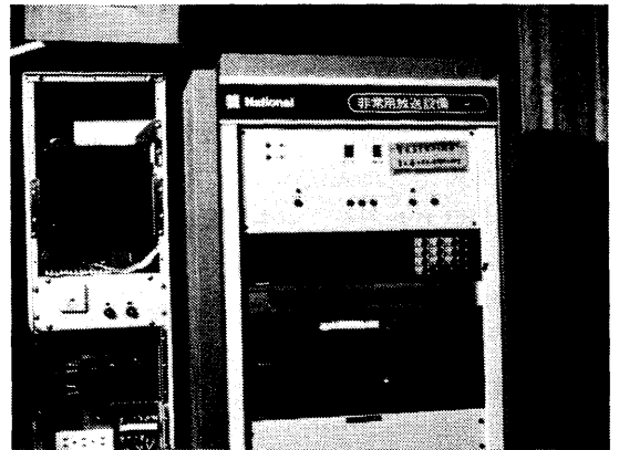
写真1 放送室にある非常用放送設備
