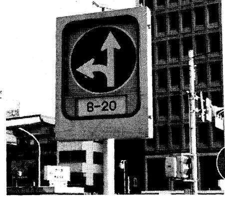
写真4 路側式可変標識角型
