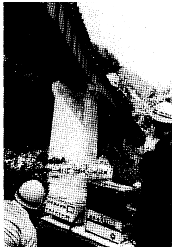
写真3 橋りょうの振動沈下試験
