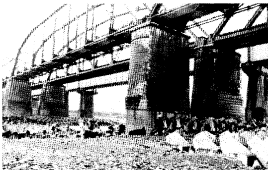
写真5 ブロックで固めた被災前の橋りょう
