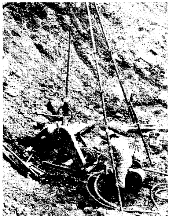
写真5 地点Iにおけるボーリング調査
