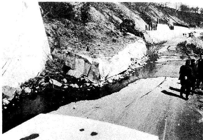
写真1 災害発生翌朝の現場道路。コンクリート擁壁が倒れているのが見えるが、この下に乗用車が下敷きとなり、2人の青年の生命が奪われた。
