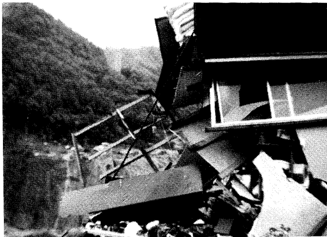
写真5 東地区の被害状況
