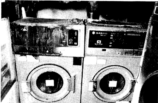
写真2 火災になったコインランドリーの乾燥機
