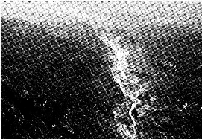
写真3 御岳山から流れ下った土石流の跡
