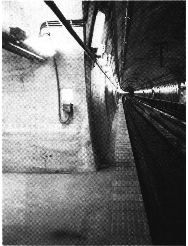
幅70cm、長さ500 mのプラットフォーム。手前左側の空間が避難誘導路。レールは列車が転覆しにくいよう(乗り心地もよい)、継ぎ目のないロングレール(1本の長さ52.57km)になっている。
