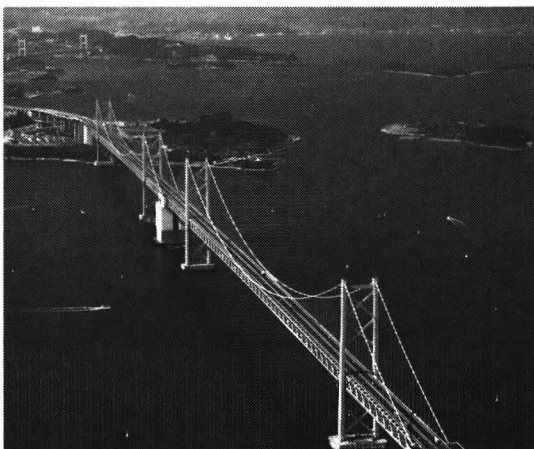
吊り橋（南備讃瀬戸大橋）
