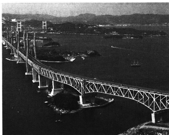
トラス橋(与島橋)
