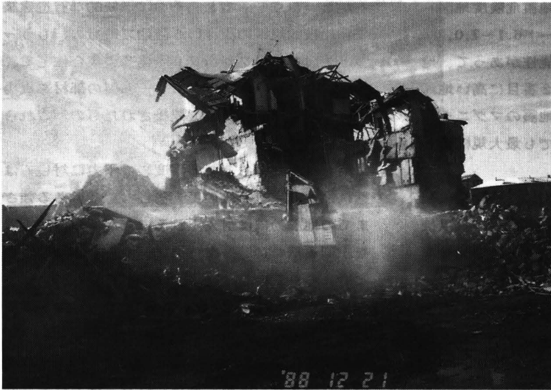
I-1 ほぼ震央に位置するスピタク市の中央部で、大部分が崩壊した補強石造によるアパートの解体作業が進められている
