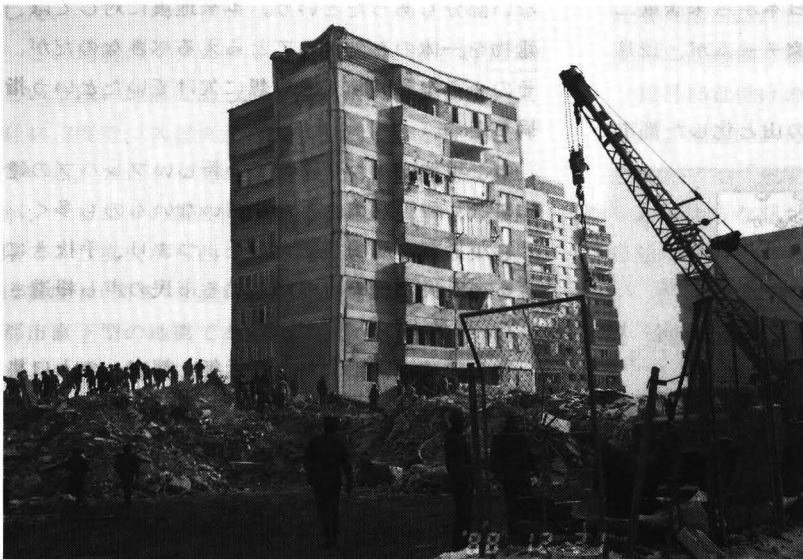
I-2 震央の西方約35kmに位置するレニナカン市の住宅団地で、多数の同種建物が崩壊した瓦礫の中に、かろうじて残っている崩壊寸前のプレキャスト鉄筋コンクリートラーメン構造のアパート(写真は1、2とも建設省広沢雅也氏による)
