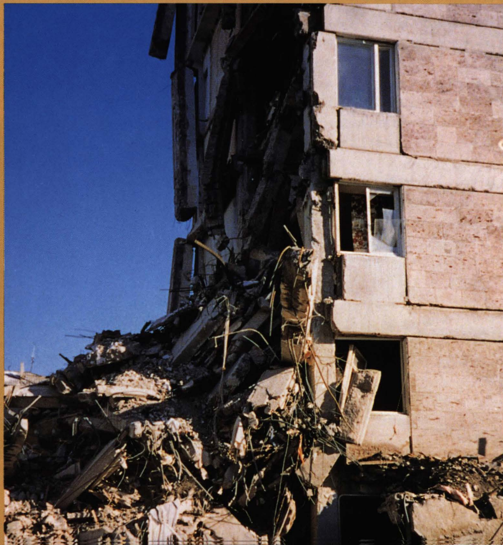
写真9：写真8の建物の一部。残った建物からはりは垂れ下がっているが、床はすべて落下している
