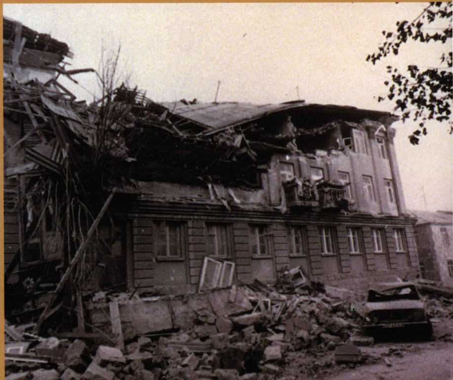
写真4：街道沿いに建つ補強石造アパート群の被害
