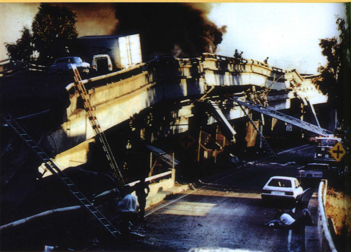
上階部分が約1.6キロにわたり陥没、1階部分に覆いかぶさるように崩壊したオークランドの国道・二層式高速道路880号線
