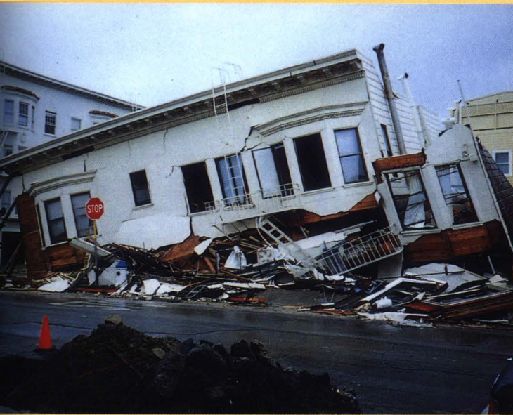
1階部分がつぶれた住宅(マリーナ地区)
