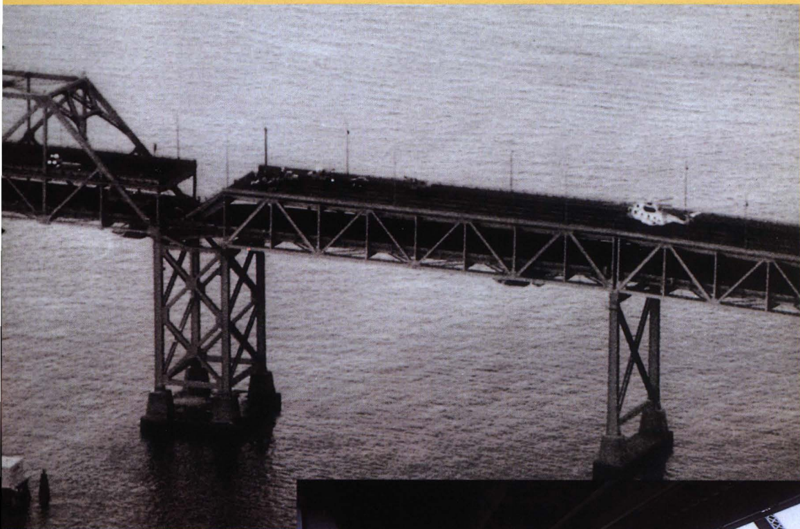
上層路面の一部が下層路面に崩落したサンフランシスコとオークランド間にかかるベイブリッジ
