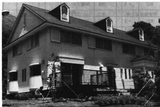
写真7 バックアップリングを有する鉛入り積層ゴムを用いた木造免震住宅
