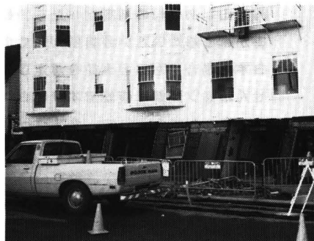
1階部分が壊れた木造4階建て共同住宅（マリーナ地区）
