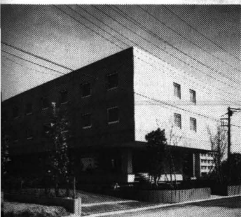
写真8 千葉県船橋市の免震建物(低減衰積層ゴムと粘性ダンパーを用いた免震構法)
