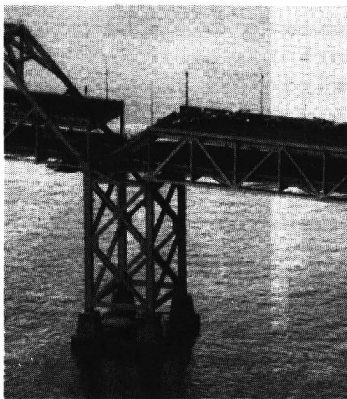
ベイブリッジの桁の落下
