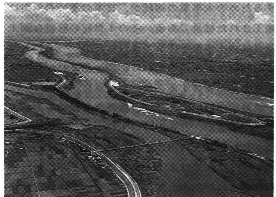
写真2 三川分離された現在の木曾川(同上)
