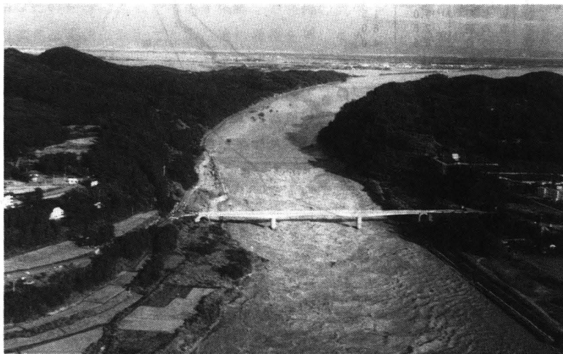
写真3 信濃川の大河津分水河口部(建設省長岡工事事務所提供)
