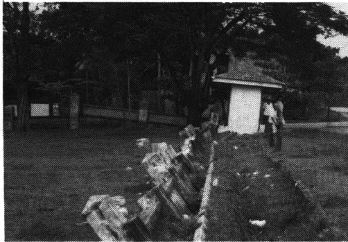
プーラの液状化による軽量構造物の傾斜 地表近くまである砂層が流れ、地表のあらゆる物が傾いている。
