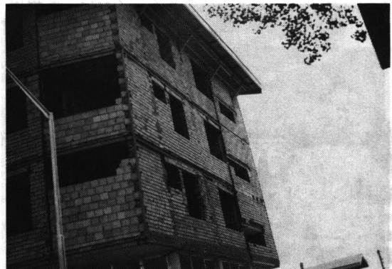
写真8 レンガ製の床を重ねて建てた中層建物(ラシュト)
