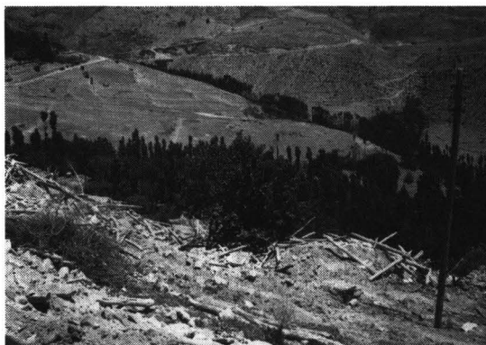
写真13 村中が土砂に埋まったケリシヨンの町
