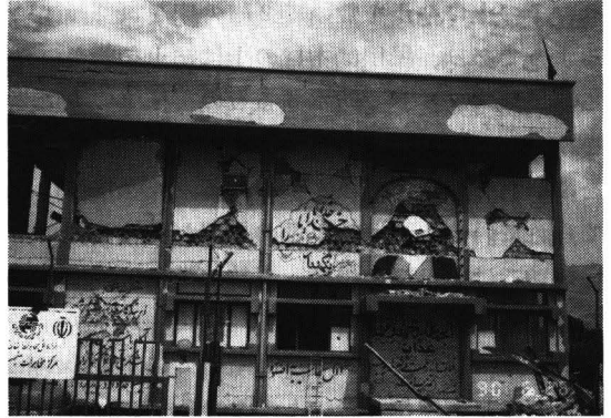
写真10 RCとレンガの混合構造の建物(マンジール)
