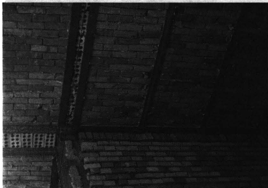
写真7 細い鋼材を支えに、レンガを組んで壁と床をつくる構法(ラシュト)
