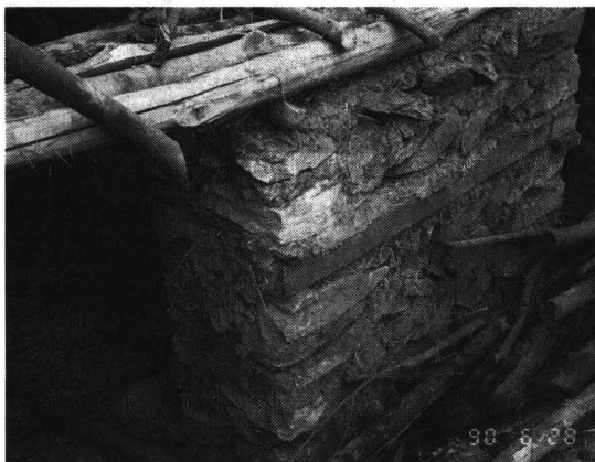
写真12 レンガや石を積み上げてつくる山岳地帯の伝統的な構法
