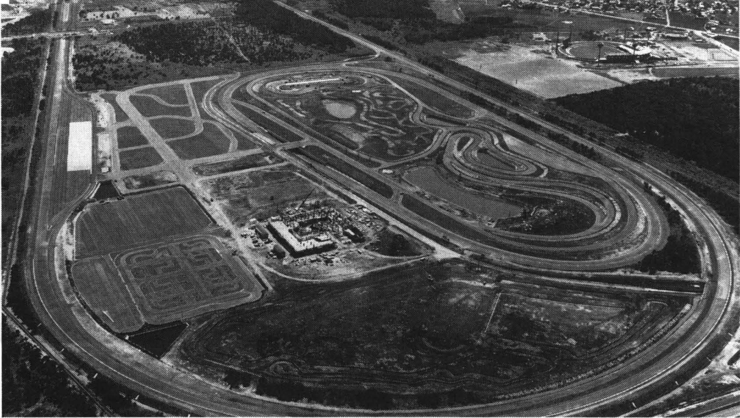
安全運転中央研修所全景（平成2年7月撮影）
