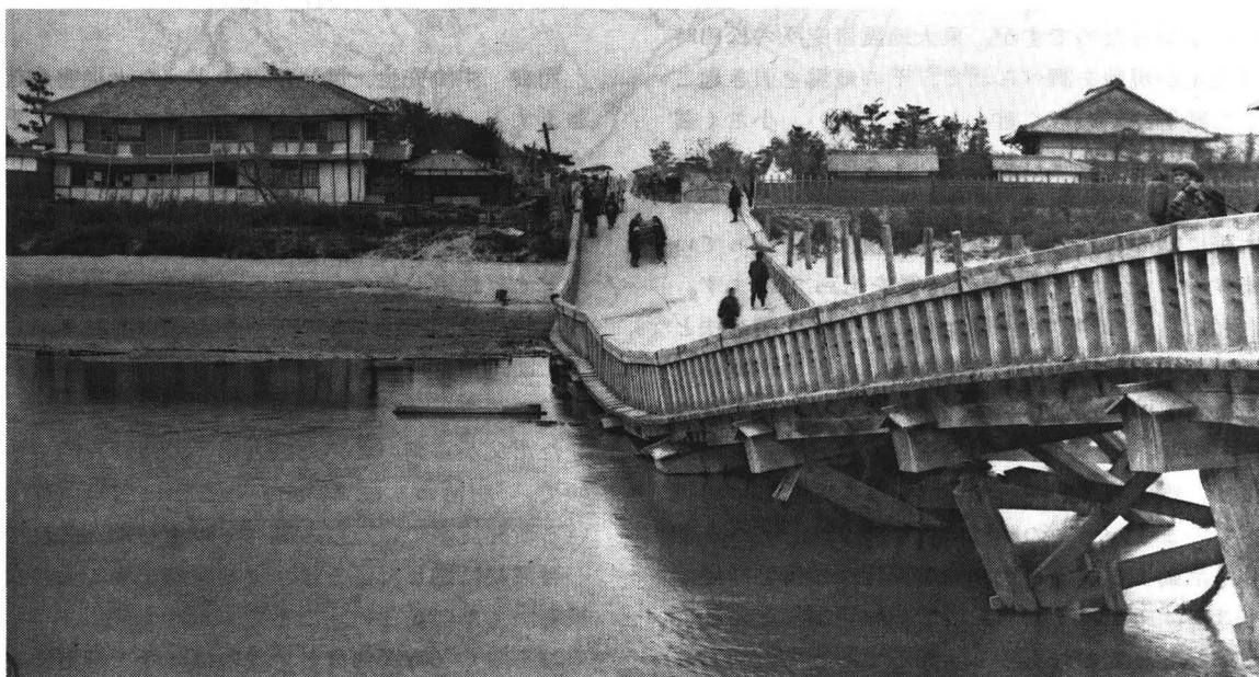
枇杷島橋の落橋
