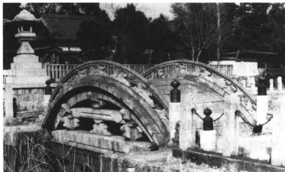
写真1 伊賀八幡宮の神橋(岡崎市)
