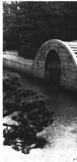
写真2 縮景園の跨虹橋(広島市)
