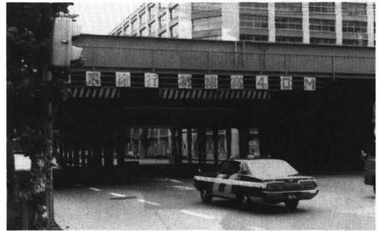
写真6 橋桁の防護工
